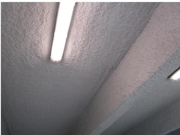
Die Beleuchtungsanlage besteht aus 27 Feuchtraumleuchten. Erfahrungsgemäß werden die Fassungen der Leuchtstoffröhren mit der Zeit poröse und brechen. Hier sollte mittelfristig eine Sanierung mit gleichzeitigem Deckenanstrich erfolgen.
