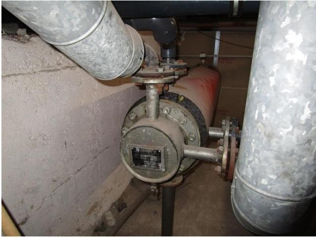
Der Wärmetauscher stammt aus dem Jahr 1984 und muss mittelfristig erneuert werden.
