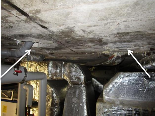
Im Bereich der Bodenabläufe und Rohrdurchführungen kommt es immer wieder zu Undichtigkeiten. Hierzu müssen die Fliesen ausgestemmt werden und eine entsprechende Abdichtung aufgebracht werden.
