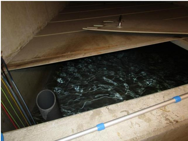
Der Schwallwasserbehälter besteht aus einer Betonwanne. Diese ist jedoch aufgrund der Beschaffenheit nicht 100 % zu reinigen. Aus diesem Grund ist vorgesehen, den Innenbereich zu fliesen, damit eine ordnungsgemäße Reinigung jährlich durchgeführt werden kann.
