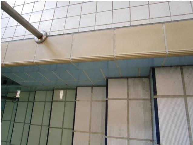
Die elastischen Fugen lösen sich zum Teil und müssen erneuert werden. Im Bereich der Zugangstreppe ist im Keller eine Undichtigkeit zu erkennen (siehe Foto 3). Die genaue Ursache kann erst geklärt werden, wenn das Becken entleert wurde.
