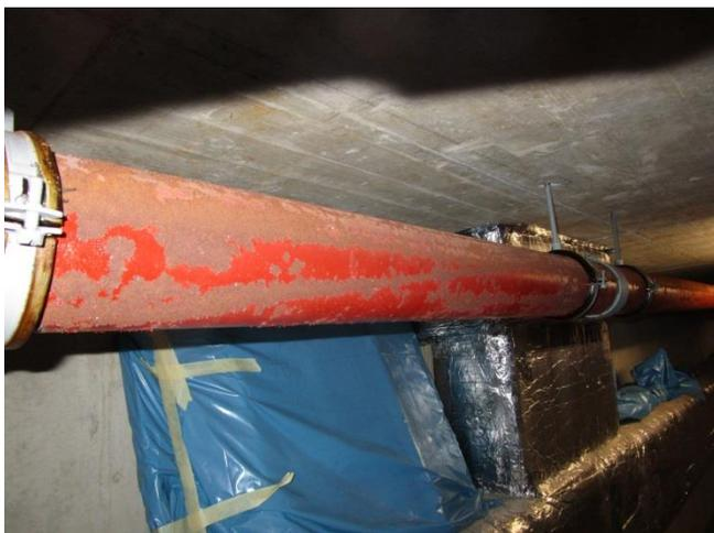
Im Bereich des Beckenumgangs befindet sich eine Abwasserleitung. Aufgrund des chlorhaltigen Wassers ist diese bereits stark angegriffen und musste in Teilbereichen schon erneuert werden. Hier ist mittelfristig die komplette Erneuerung der Abwasserleitung vorzusehen.
