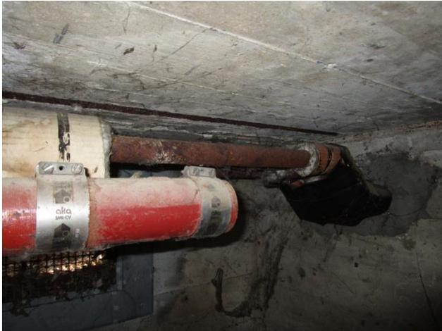
Die Heizungsrohrleitungen stammen aus dem Jahr 1962 und sind an einigen Stellen schon stark korrodiert. Hier sollte mittelfristig eine Sanierung erfolgen
